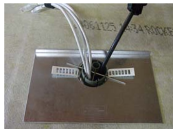
Prefab in geheel door de tegel steken. In het schakeltje zitten twee slobgaten die in de metalen pennen vallen.
