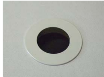
Rozet in de plafondtegels plaatsen.
