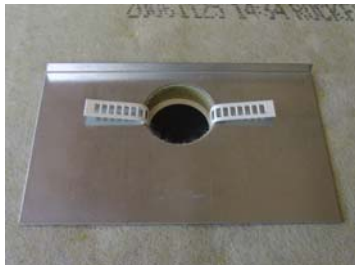
Plaats de metalen plaat op de plafondtegels. Vouw de flappen van de rozet om.
